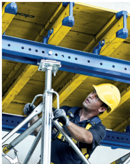
Безопасная подгонка по высоте благодаря простой юстировке головных и опорных шпindelей даже под нагрузкой.
