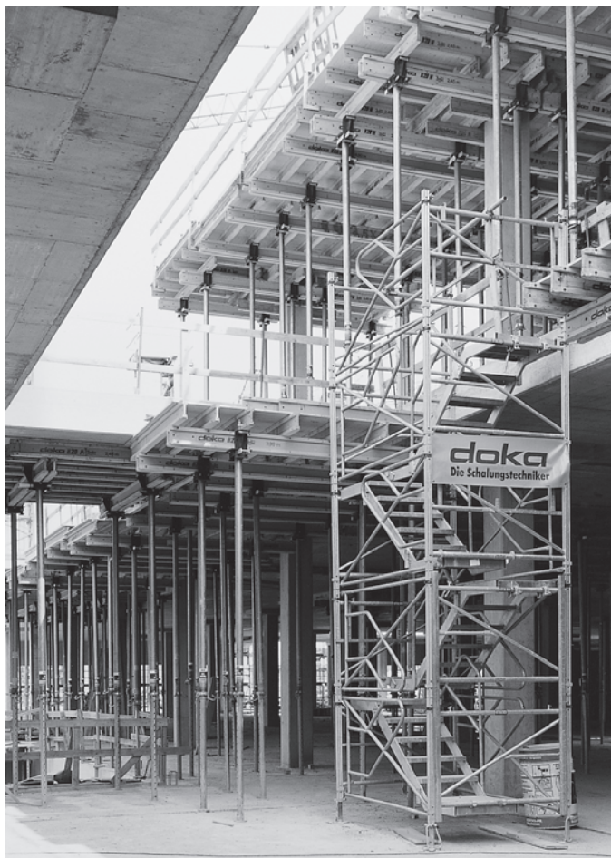
Строительная площадка: ARGE Westmünster Center, г. Бохолт
