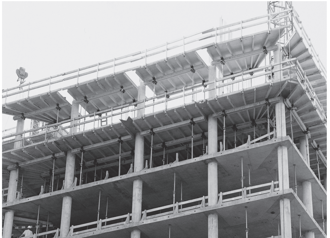
Строительная площадка: ARGE LVM - высотное здание, г. Мюнстер
