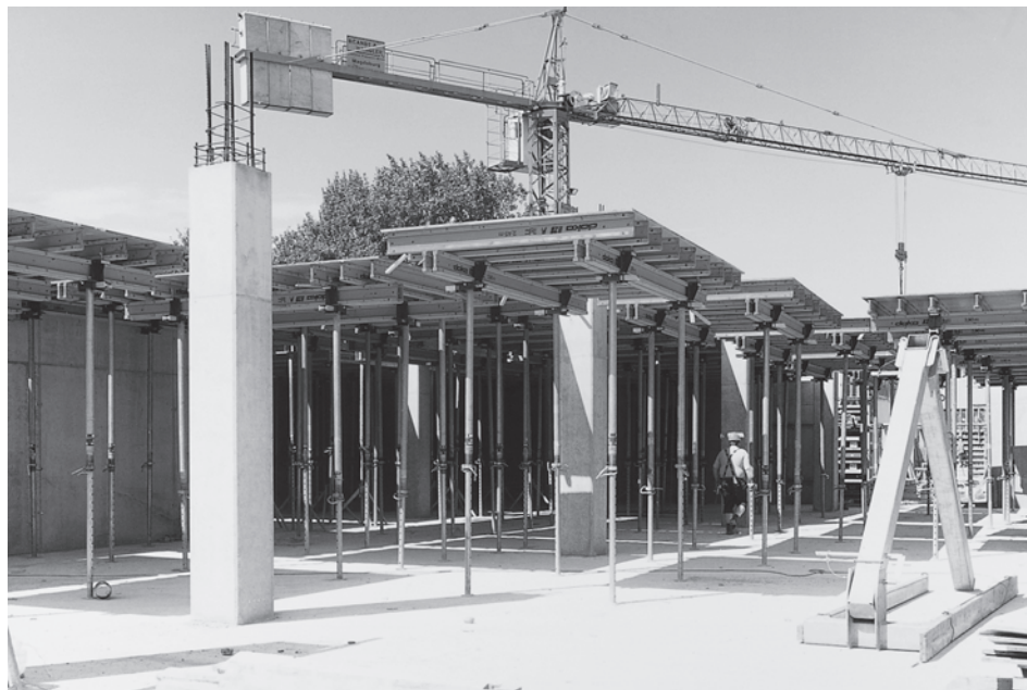
Строительная площадка: Университетская клиника в г. Магдебурге
