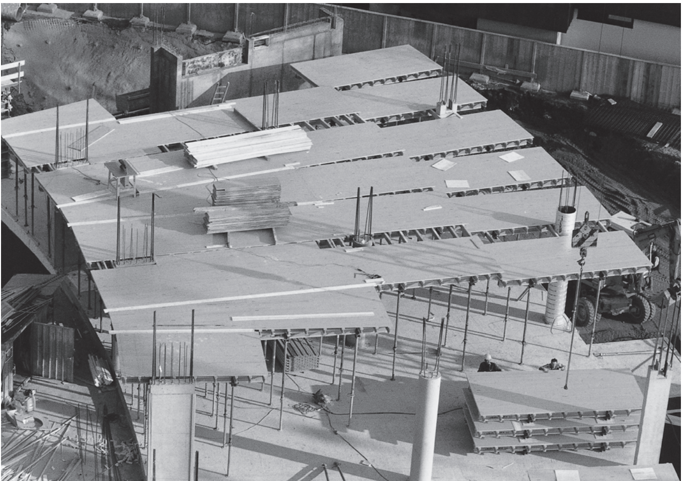
Строительная площадка: Chirurgie West, г. Зальцбург
