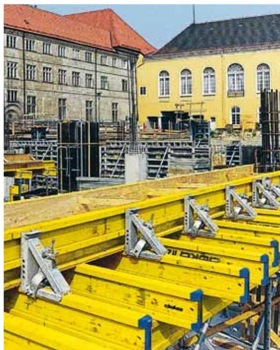
Легкое возведение опалубки для прогонов с помощью балочного зажима 20
